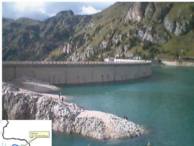
La Diga di Forte Buso
