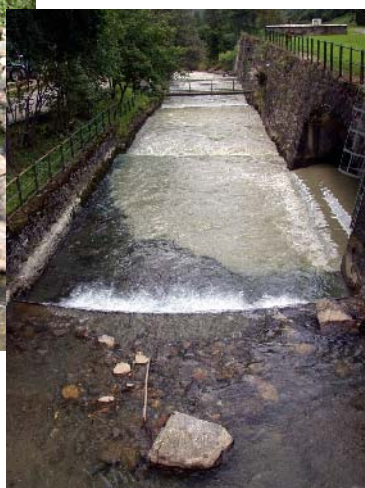
A valle dello scarico della centrale
