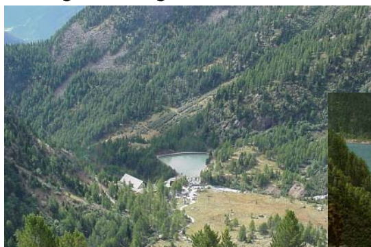
Diga di Malga Mare
